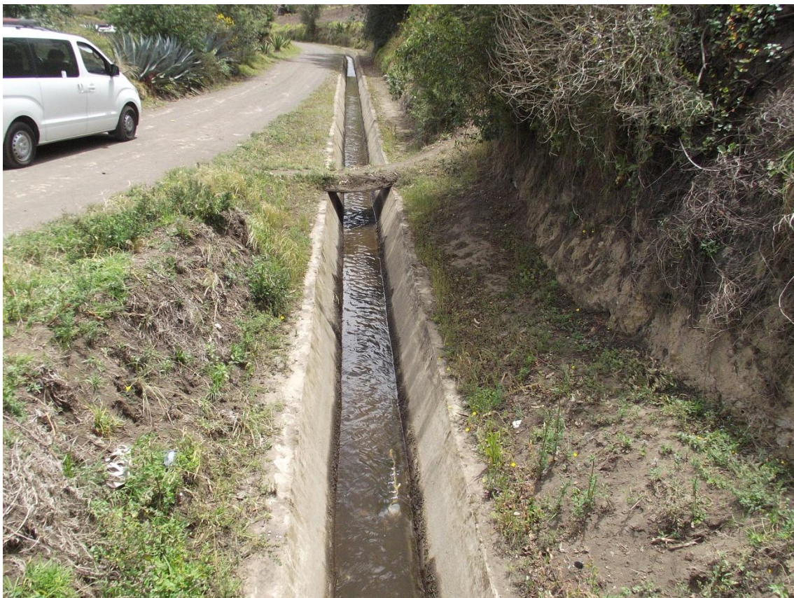
Foto 4-2 Canal de agua Huachi- Pelileo
