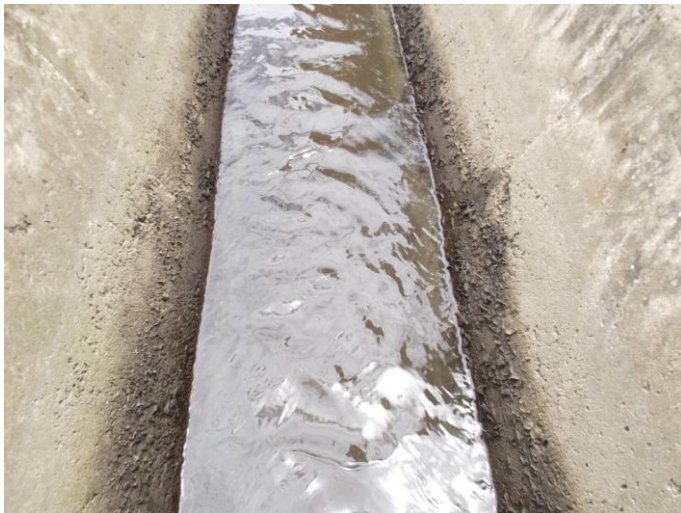
Foto 6-5 Alteración del agua del canal Huachi - Pelileo
