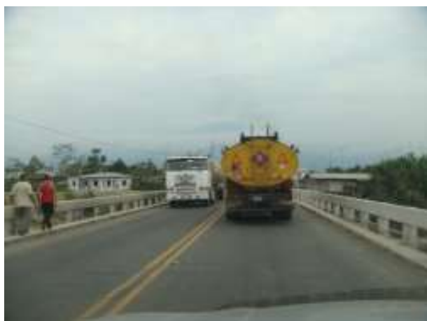
Fotografía 3: Puente Alterno Norte
